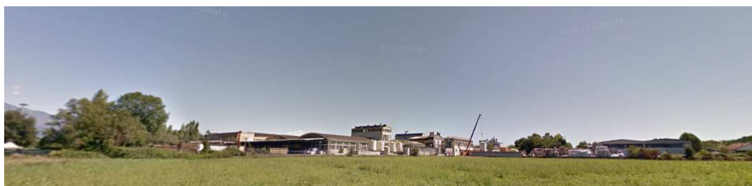
Vista della CARTIERA GIACOSA Spa (stabilimento a rischio di incidenti rilevanti) da via Babiasso
